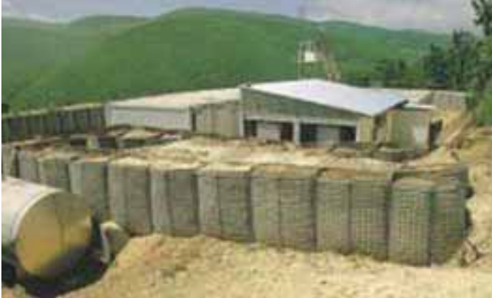
Спостережний пункт (СП) із захистом від прямого вогню великого калібру
