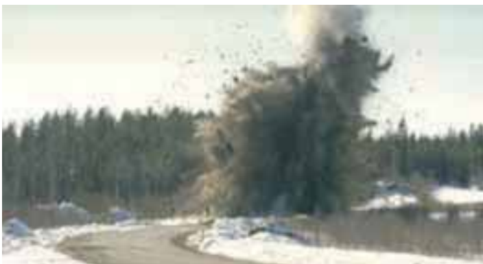
Підрив дорожнього насипу
